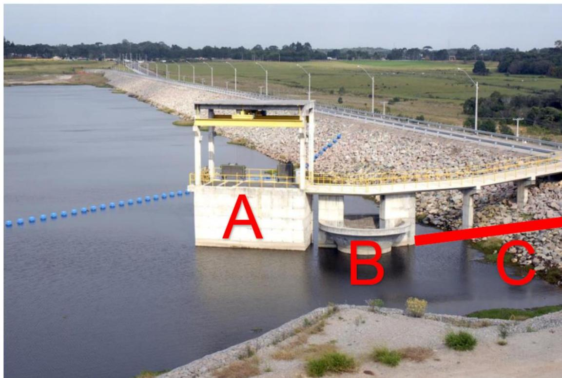
Figura 1: Na imagem observamos: A) Tomada d'água. B) Tulipa. C) Galeria de fundo (indicada com a linha vermelha, pois é subterrânea).
