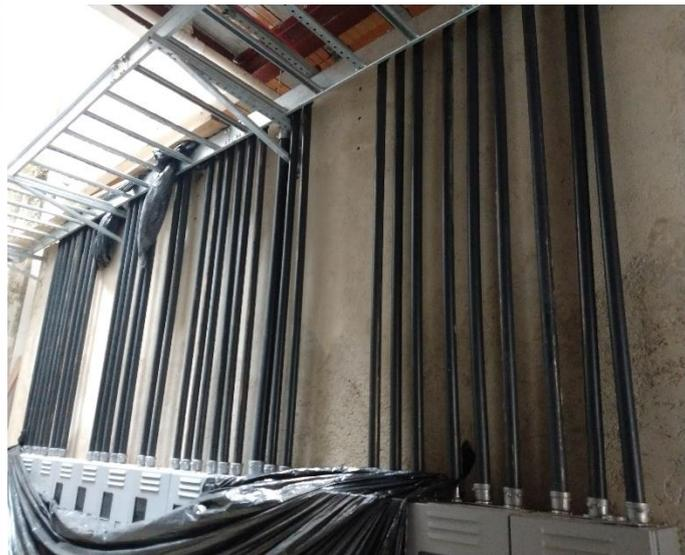
**FOTO 13 E 14:** DETALHE DA EXECUÇÃO: ELETRODUTOS DE PVC SITUADO NO ESTACIONAMENTO PARA OS QM.
