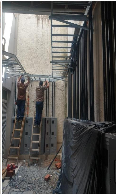
**FOTO 15 E 16:** DETALHE DA EXECUÇÃO: ELETRODUTOS DE PVC SITUADO NO ESTACIONAMENTO PARA OS QM.
