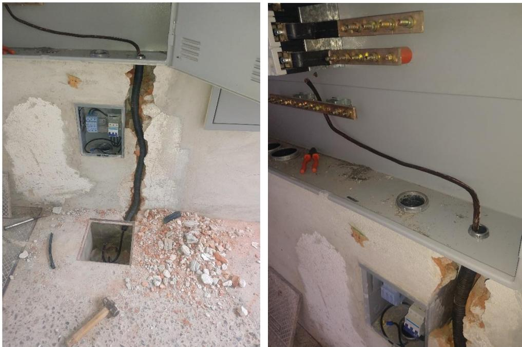
**FOTO 1 A 4:** DETALHE DA EXECUÇÃO DO ATERRAMENTO NAS CAIXAS DE PASSAGEM NOS QUADROS SITUADOS NA ENTRADA DO ESTACIONAMENTO.
