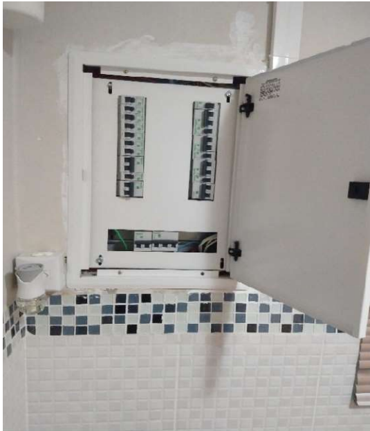
Novo Quadro de Distribuição banheiro masc. 8º andar
