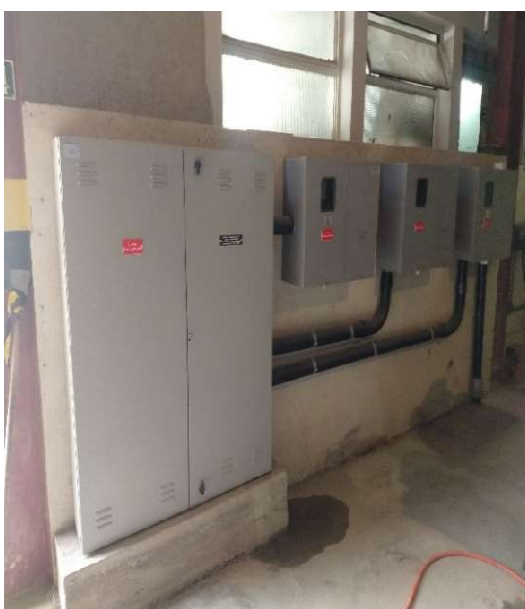
Medidores e QD, localizados no estacionamento, todos ligados com novos ramais.
