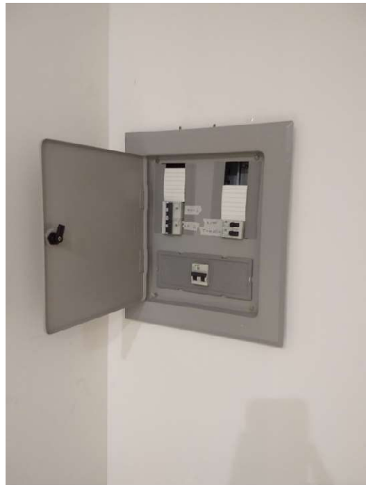
Novo Quadro de Distribuição sala 01 6° andar
