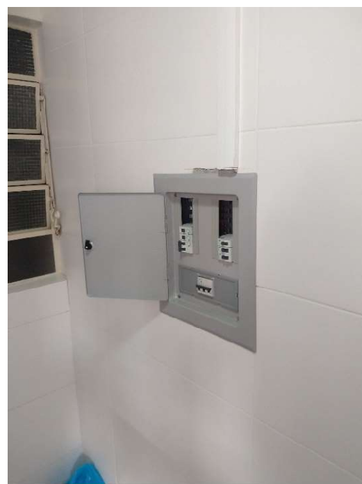
Novo Quadro de Distribuição banheiro social sala 02 12º
