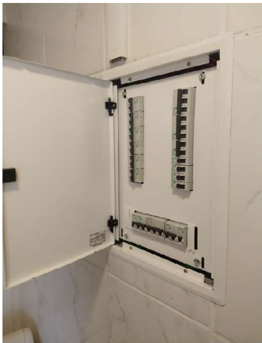
Novo Quadro de Distribuição banheiro fem. 10º andar
