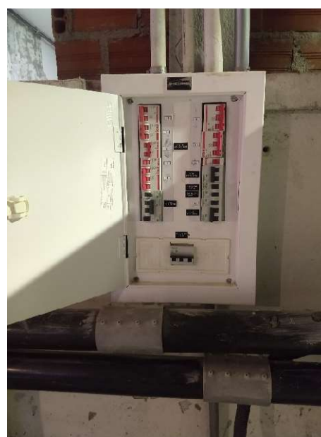
Medidores e QD, localizados no estacionamento, todos ligados com novos ramais.
