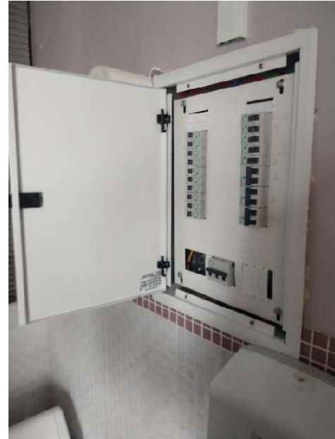
Novo Quadro de Distribuição banheiro masc. 9º andar.
